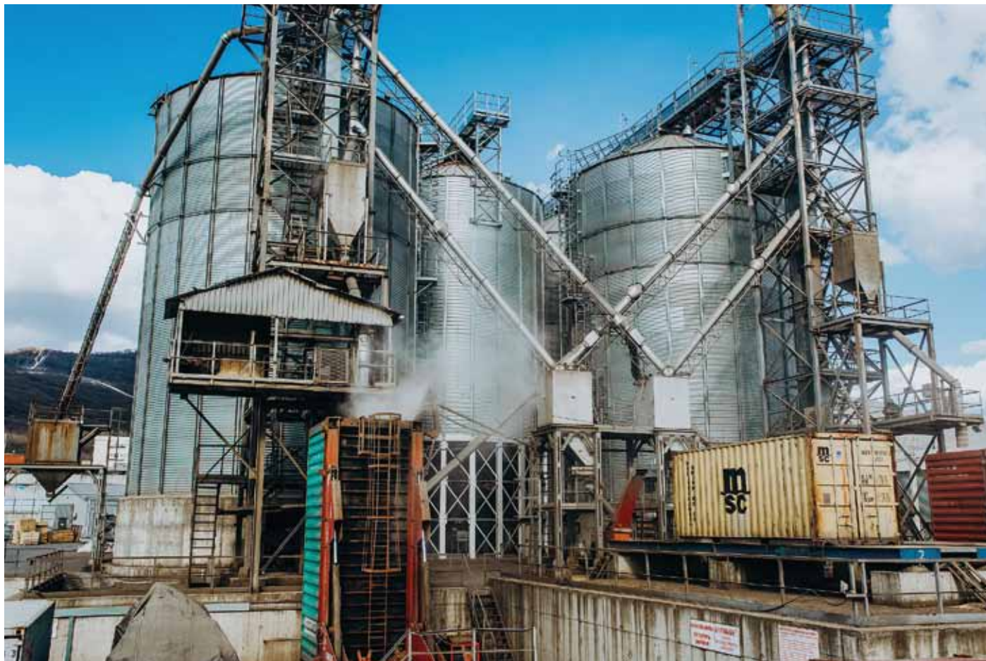
Загрузка контейнера на зерновом терминале
