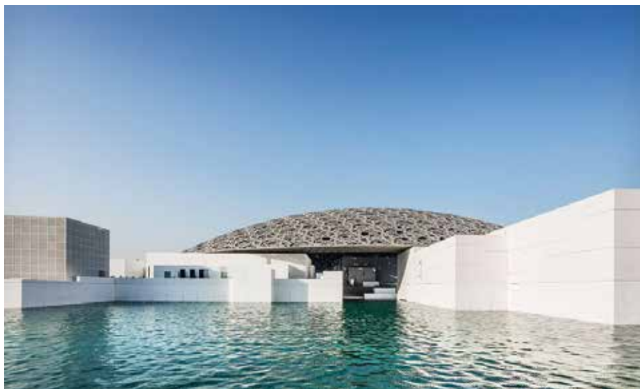
Использование композитной сетки ROCKMESH и дюбелей THERMOSAVE производства ООО «Гален» в строительстве музея Лувр Абу-Даби
