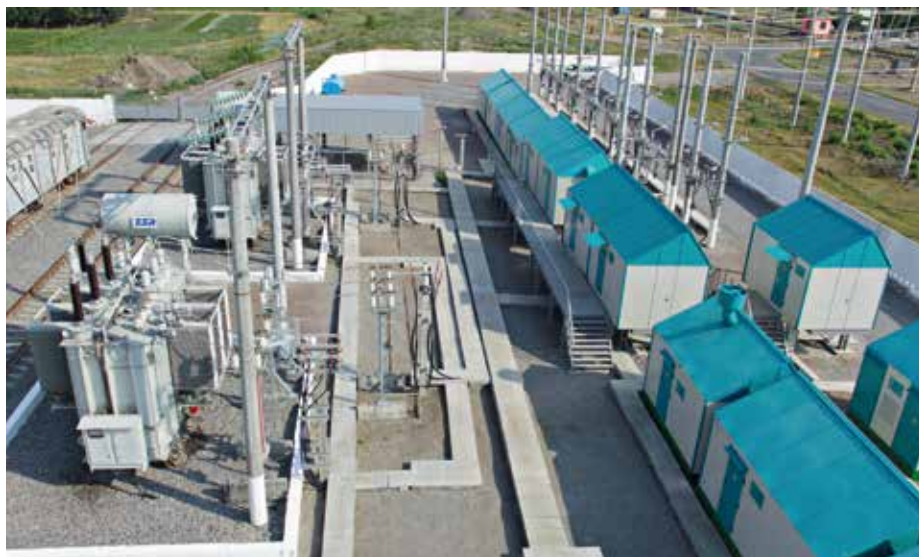
Тяговая подстанция на железной дороге
